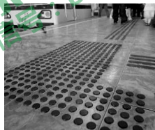
盲道由凸起的棱和圆点组成
