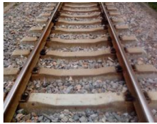
铁轨铺在枕木上
