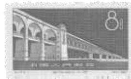
武汉长江大桥
