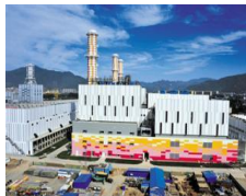
C. 燃气电站
