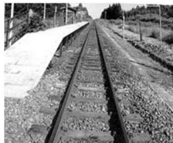
铁轨铺在枕木上
