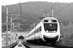
中国承建的首条国际高铁——安伊铁路
