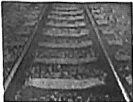
在铁轨下面铺枕木
