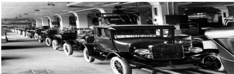
1913年，亨利·福特开办的制造福特T型汽车的流水线
