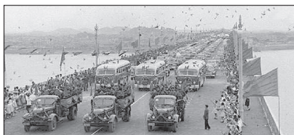
1957年武汉长江大桥建成
