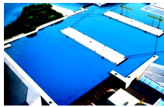
乙：管节起浮移位
