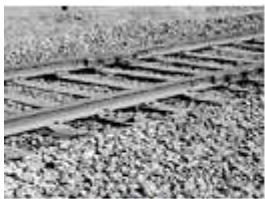
铁轨下铺枕木
