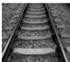
在铁轨下面铺枕木
