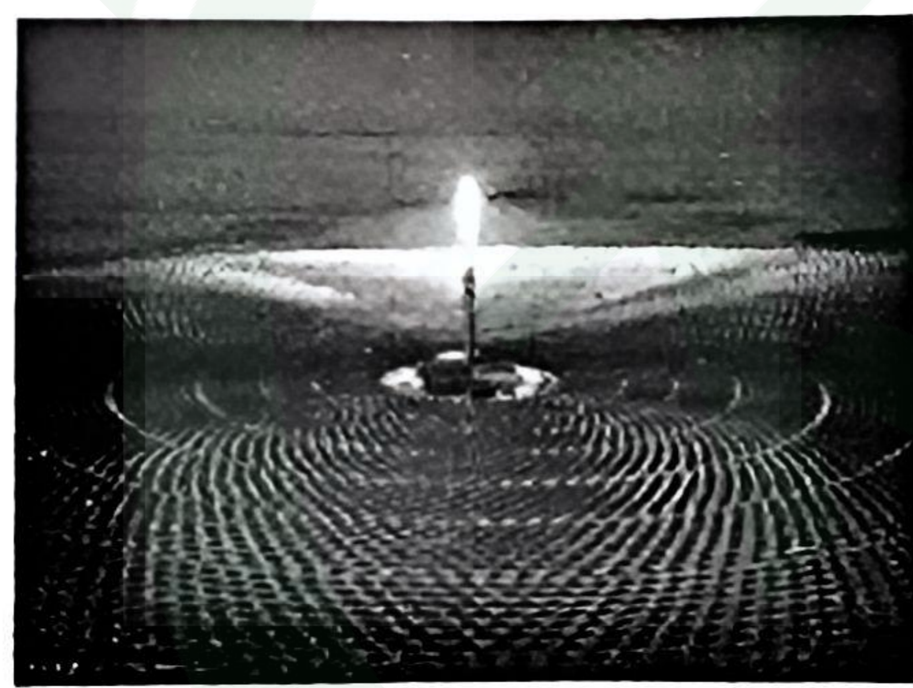
俯瞰光热电站
