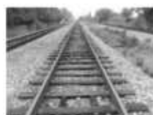
铁轨铺设在枕木上 D
