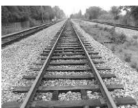
铁轨铺设在枕木上 D
