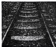
铁轨铺在枕木上
